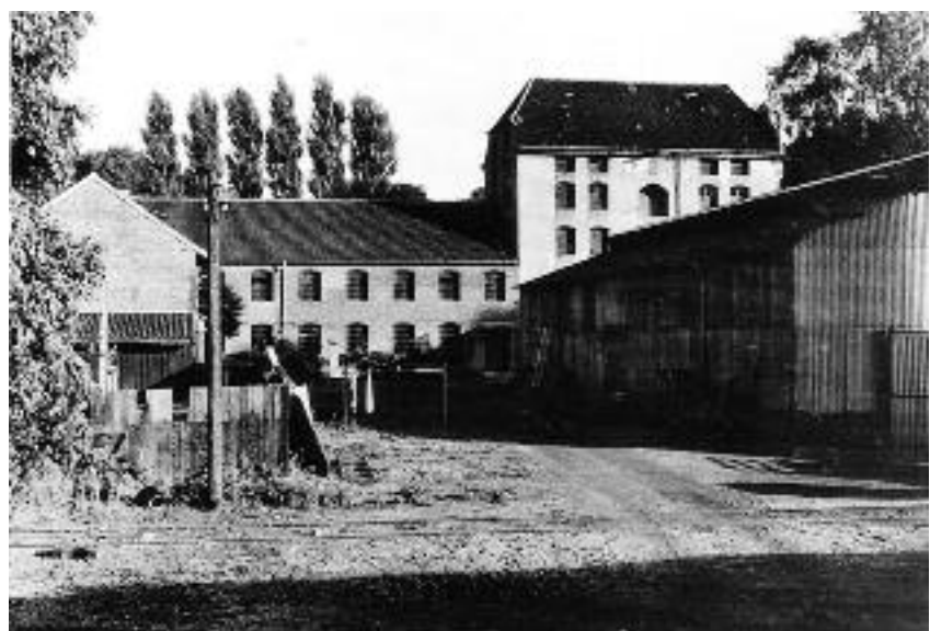
Blick auf die „Hohe Fabrik“ (heute Museum). Rechts der Baumwollschuppen, im Vordergrund der Gleisanschluss zur Angertal-Bahn
