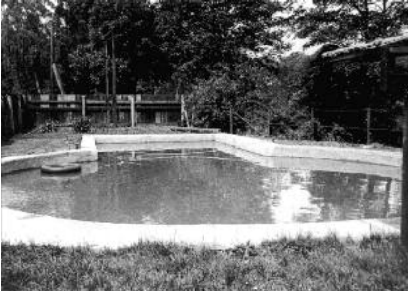
Aus dem Fundament eines ehemaligen Gasometers wurde ein rundes Schwimmbad für die Familie Gemmert und die Belegschaft der Fabrik. Später wurde ein viereckiges Nichtschwimmerbecken angebaut
