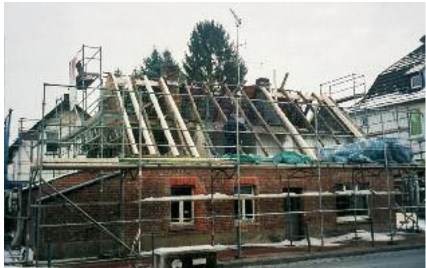
Ausbesserung des Dachstuhl im Februar 2010. Der alte Farbanstrich wurde bereits beseitigt
