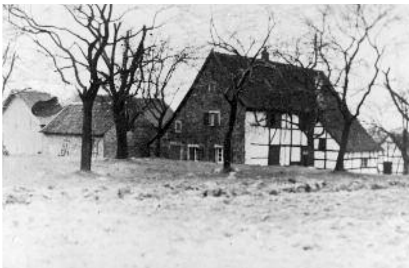
Der Hof „Dohrenbusch“ in Breitscheid in den 1920er-Jahren. Er liegt heute zwischen der A 52 und dem Kahlenbergsweg
