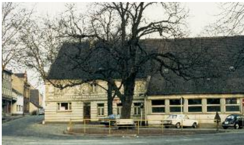
Die Gaststätte „Peter Holtschneider“ am alten Lintorfer Markt war Gründungslokal des Lintorfer Heimatvereins. Das Haus wurde 1969 niedergerissen
