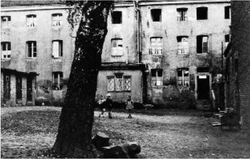
Rückseite der Wohnhäuser an der Cromford Alley
