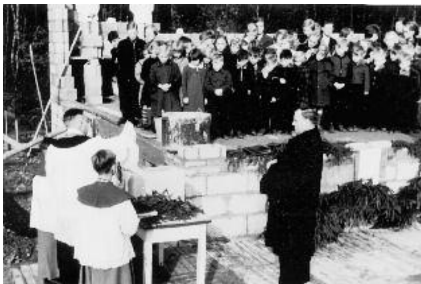
Grundsteinlegung für das neue Schulgebäude am 7. November 1953 durch Direktor Breitenstein und Dechant Heinrich Schwering aus Duisburg
