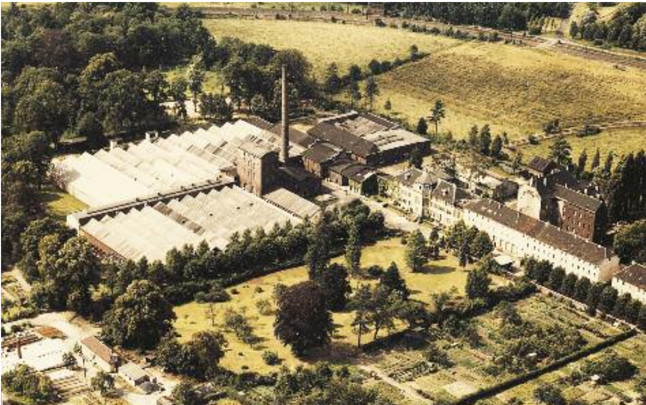
Die Joh. Gottfr. Brügelmann GmbH in Cromford im Jahre 1958. Links unter den Sheddächern die Weberei mit dem Wasserturm und dem Schornstein neben dem Turbinenhaus. Im Hintergrund erkennt man die Angertalbahn mit dem auf die Fabrik zulaufenden Werksgleis. In der Mitte das Herrenhaus, hinter den Arbeiterwohnungen die „Hohe Fabrik“, das heutige Museum. Links daneben der Baumwollschuppen
